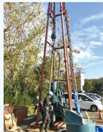
▲井戸の掘削作業
