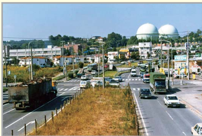
「亀の甲」交差点の こどうきょう 跨道橋設置前の景観
