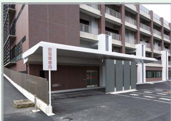
救急車専用搬入口
