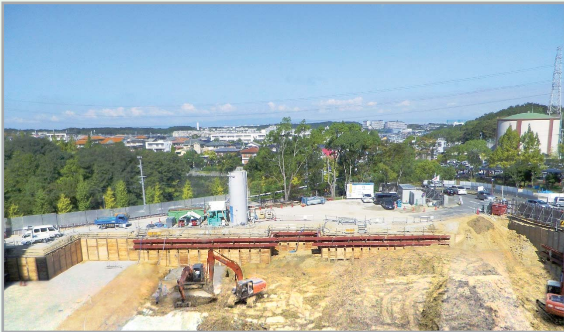
基礎工事（平成24年10月時点）
